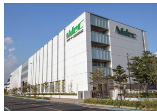
NIDEC Shin-Kawasaki Technology Center ニデック新川崎 テクノロジーセンター
