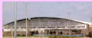
▲建築中のベトナム日本電産(06年6月稼働予定)
