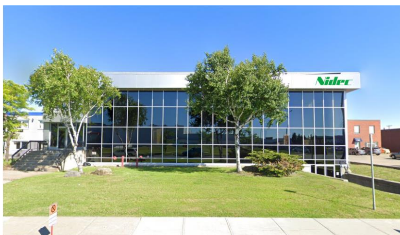
日本電産リード・インスペクション・カナダ株式会社 新本社
