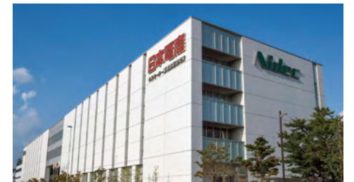
导入了清洁电力证书系统的中央马达基础技术研究所
