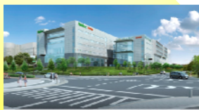
生産技術研究所（2018年1月竣工予定）
