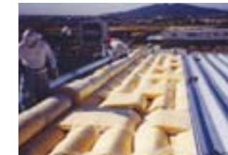
滋賀技術開発センター 断熱屋根の採用
