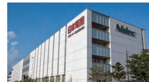
再生可能エネルギー100%電力を導入している中央モーター基礎技術研究所
