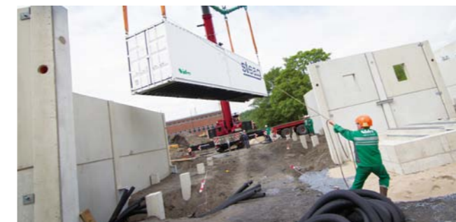
ドイツの電力貯蔵システム
