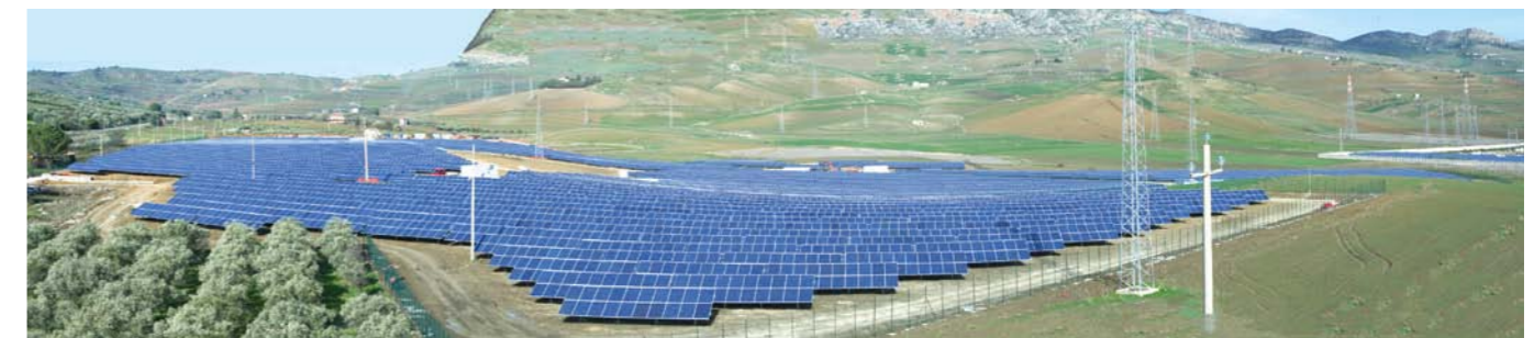
イタリア・シシリャ島チミンナ郊外に設置された太陽光発電プラント
