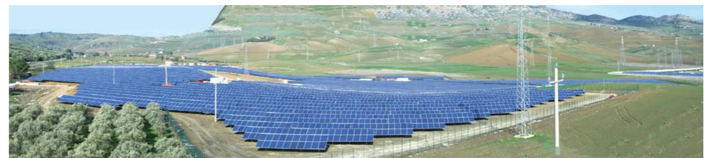
位于意大利西西里岛奇明纳郊外的太阳能发电厂
